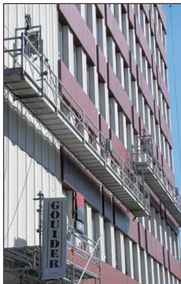
■ Mise en œuvre d'un bardage et nettoyage d'une façade ciment
