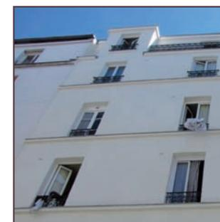
■ Piochage 100 % enduit chaux (St Astier), recouvrement en zinc
