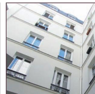
■ Face en plâtre, réalisation d'un enduit micro-mortier à la chaux (St Astier)
