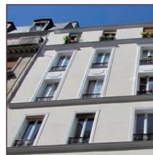
■ Reprise des enduits plâtres et modénatures finition, badigeon lait de chaux
